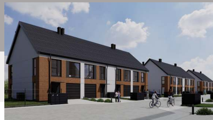
Widok od strony ulicy
